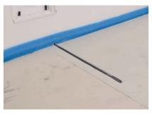
Für ideale Messwerte Bodenfühlerhülse bündig mit der Oberseite abschließen lassen.
