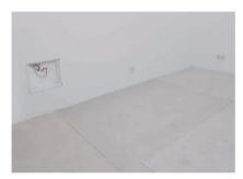
Ebenen, sauberen, tragfähigen Untergrund vorbereiten. Trockenestriche und Holzwerkstoffplatten sind stets zweilagig und im Versatz auszuführen.
