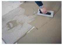
Heizfolie mit Kunststoffspachtel eindrücken und mit Klebemörtel überziehen. Knicke und Falten sind zu vermeiden.
