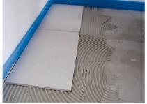
Fliesen können mit geeignetem Fliesenkleber gemäß Herstellerangaben direkt auf dem glattgezogenen Klebermörtel verlegt werden.
