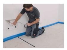
Bodenfühler durch das Lerrohr zum Messpunkt im Boden führen.
