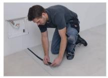
Bodenfühleranschluss-Sets in der Aussparung verlegen und die Bodenfühlerhülse mit Isolierklebeband abkleben um Fehlerströme zu vermeiden.
