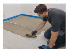
Klebemörtel gemäß Herstellerangaben auftragen.
