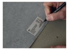
Widerstände zugeschnittener Folien erneut messen und auf Etikett sowie im Prüfprotokoll dokumentieren – Sollwerte der Montageanleitung entnehmen.
