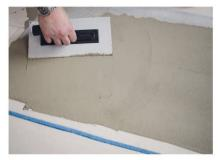
Heizfolie nicht über Dehnungsfugen verlegen und in einem Abstand von mind. 2 cm vor der Dehnungsfuge enden lassen.
