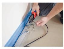
Anschlusskabel verbinden und zum Trafo führen.
