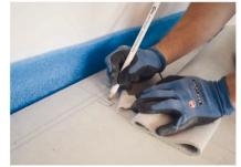
Aussparungen für die Zuleitungen und Kontaktierungen der Heizfolien ggf. nach unten nacharbeiten.
