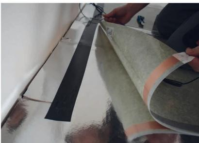
Isolierklebeband an Kopf- und Fußende in ganzer Breite unter der Heizfolie zum Schutz vor Fehlerströmen an der Schnittkante anbringen.
