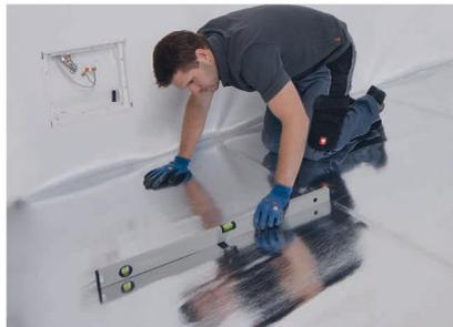
Für ideale Messwerte Bodenfühlerhülse bündig mit der Oberseite der Trittschalldämmbahn (z.B. CF DIRECT 1.5) abschließen lassen.
