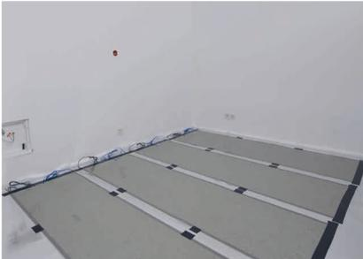
E-ENERGY CARBON PET Heizfolien untereinander ausrichten und seitlich mit Isolierklebeband fixieren (mind. 2 cm Abstand zwischen den Folien).
