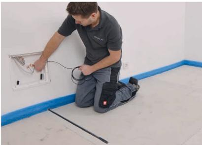
Bodenfühler durch das Lerrohr zum Messpunkt im Boden führen.
