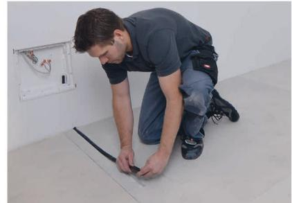
Bodenfühleranschluss-Sets in der Aussparung verlegen und die Bodenfühlerhülse mit Isolierklebeband abkleben um Fehlerströme zu vermeiden.
