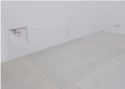
Ebenen, sauberen, tragfähigen Untergrund vorbereiten. Trockenestriche und Holzwerkstoffplatten sind stets zweilagig und im Versatz auszuführen.
