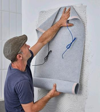
Die Carbon-Heizfolie kann einfach angebracht werden. E-Nergy Heating
