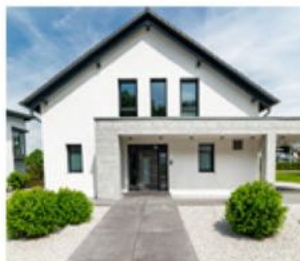
Einfamilienhaus Detached house
